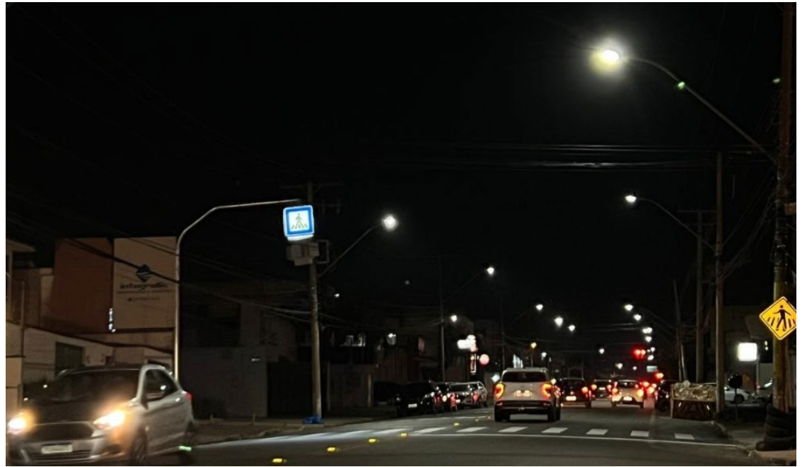
Goiânia recebe luminária que indica a presença da sinalização da faixa de pedestre: equipamento já foi instalado em alguns pontos da cidade
